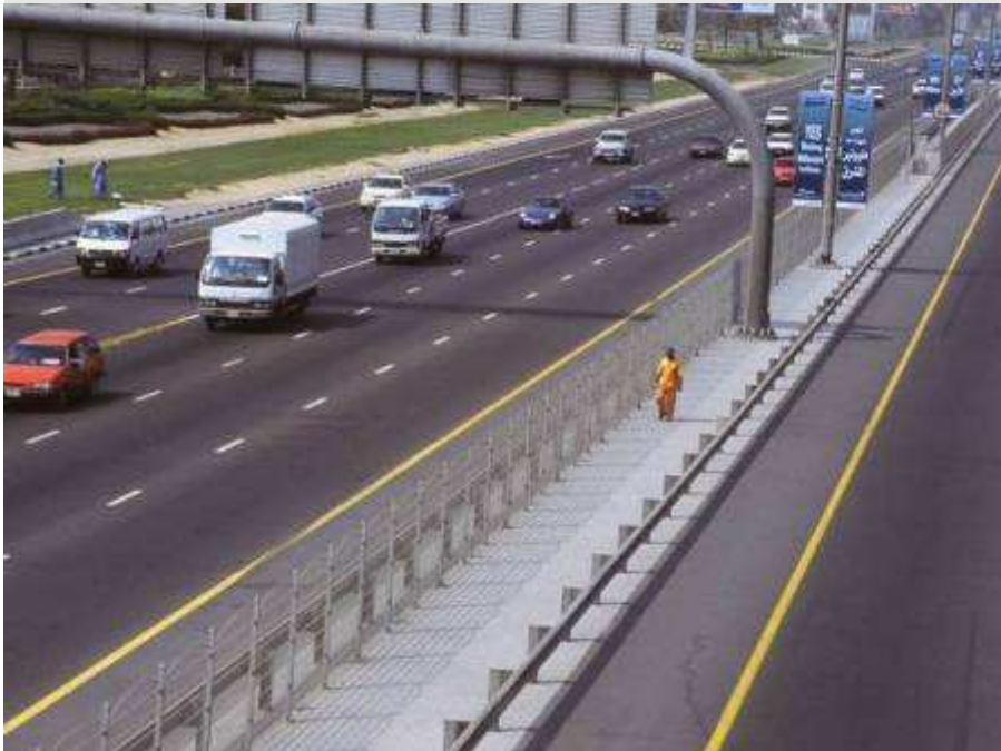
Decofor Arco – 103 km
