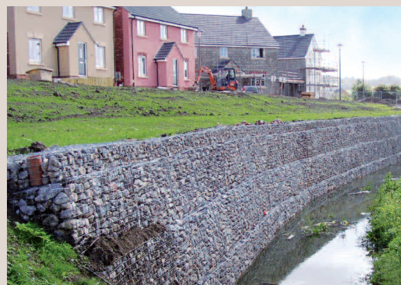
Гравитационная опорная стена с матрацами, защищающими от эрозии, Бристоль, Англия – 2004 г.
