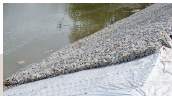
Укрепление берега матрацами из решетки Weldmesh® - Чешув, Польша - 2005 г.
