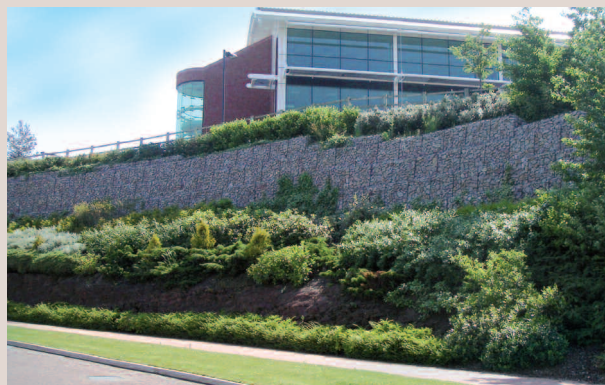
Подпорная стена из габионов в Daresbury Businesspark, Англия – 2000 г.
